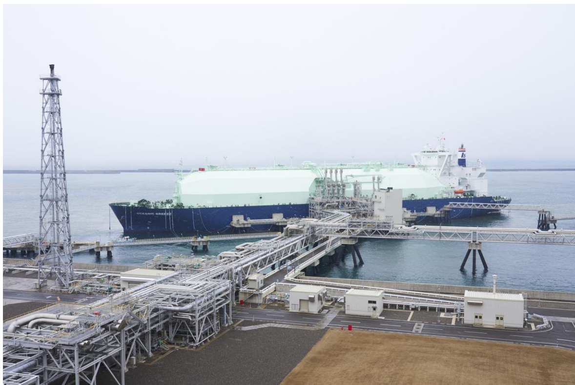
直江津 LNG 基地に初入港した OCEANIC BREEZE
