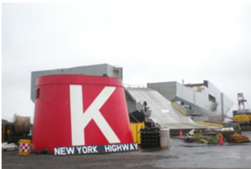
室蘭港で解体中の”NEW YORK HIGHWAY” (2010年)
