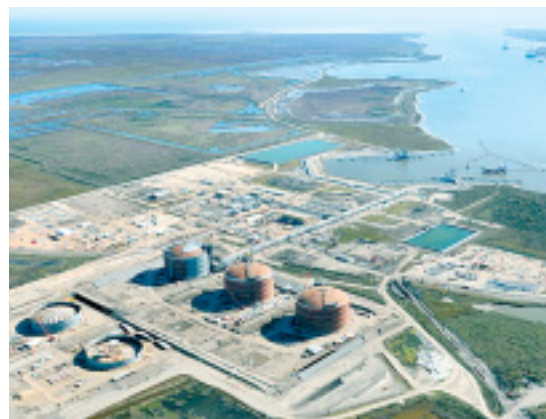
米国メキシコ湾岸に建設中のシェニエール・サビンパスLNG受入基地
