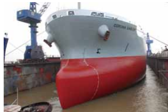
ドックでシリコン塗料(赤色)による塗装工事を実施
