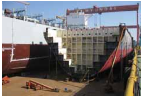
建造中のコンテナ船(船首側)
