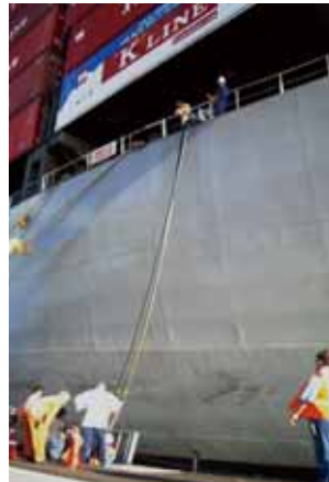
本船から下ろした電源ケーブル(接続箱へつなく)
