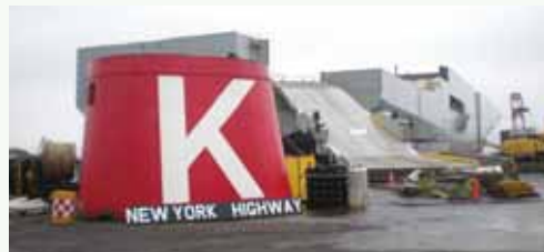
取り外された煙突(手前)と解体中の船体(後方)
