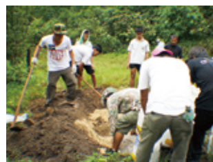
設置のため土を掘り起こしているスタッフ
