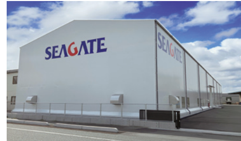
防府鋼材倉庫 （提供：株式会社シーゲートコーポレーション）
