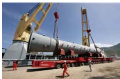
製油所向け大型リアクターの荷役作業
