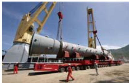
製油所向け大型リアクターの荷役作業
