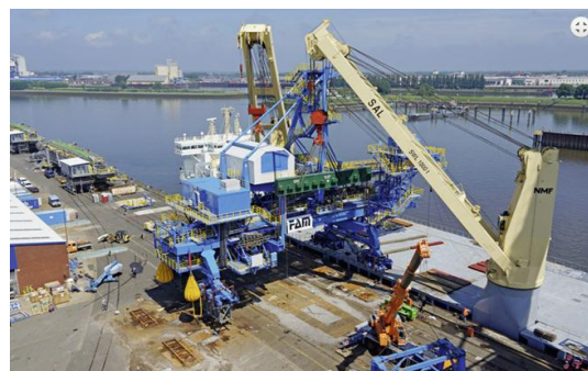
シップローダー(鉄鋼石等バルク貨物を船舶へ積み込む港湾設備)
