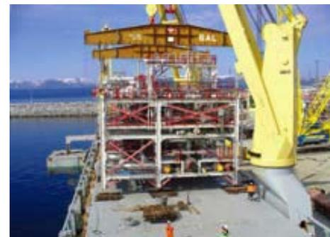
プロジェクト貨物：LNG設備の組み立て済みモジュール
