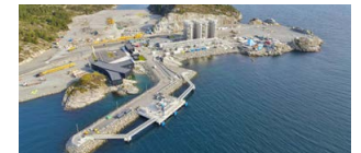
Northern Lights社のCO 2 受入基地 (ノルウェーØygarden, 建設中。提供：Northern Lights JV DA)
