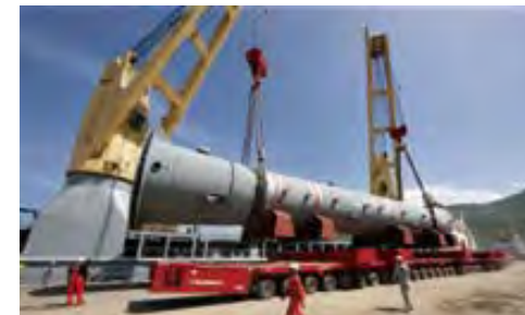
製油所向け大型リアクターの荷役作業
