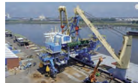
シップローダー(鉄鋼石等バルク貨物を船舶へ積み込む 港湾設備)
