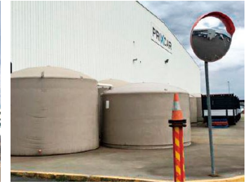
屋根からの雨水を溜める為のタンク Rainwater Tanks used to collect water from roof
