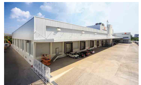
BCS 第二倉庫外観
