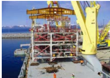
Project cargo: Assembled module of LNG plant
